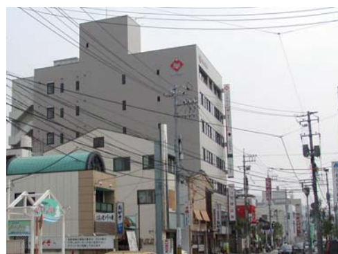
屋上ではなく、最上階の外壁に付加した切り文字
