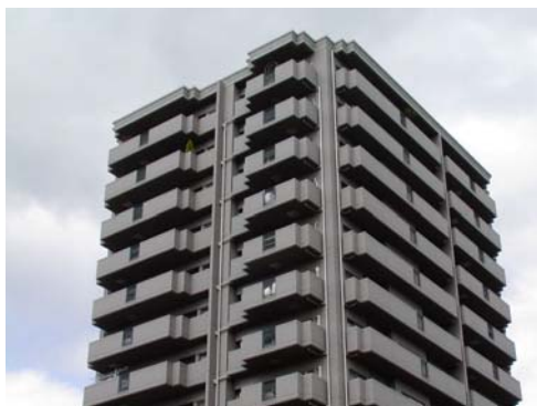
排水管の色を外壁と同系色にしている例
