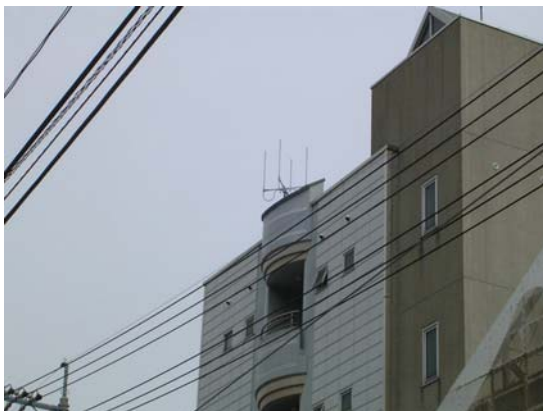
携帯電話基地局アンテナの中でも構造物が細いPHSアンテナ
