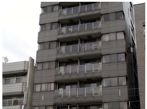
室外機を目立ちにくく配置している例
