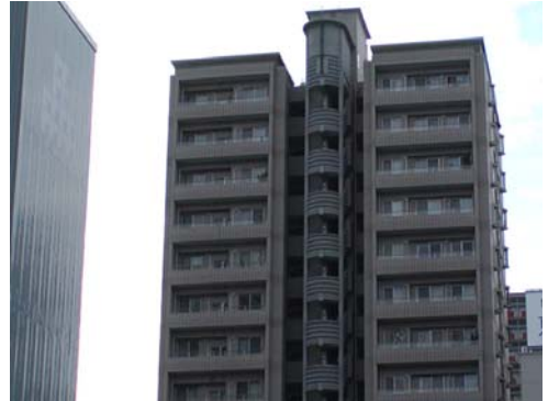
外壁面の凹凸、屋外階段の縦方向のデザイン要素としての活用により単調さを軽減している例
