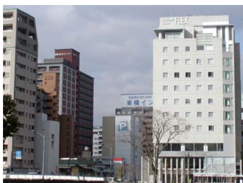
屋上の平看板と切り文字とでは、景観に及ぼす影響が明らかに違います。
