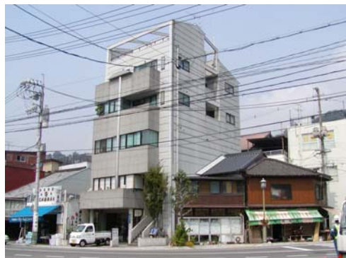
外壁面の凹凸、素材の変化、目地などによりスケール感を細やかにしている例
