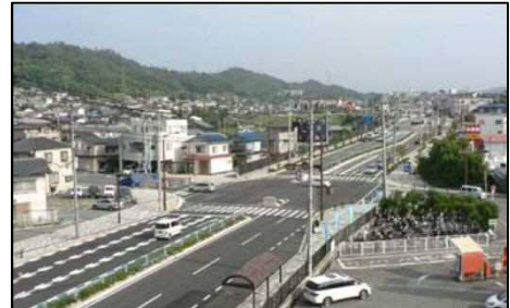
計画的な土地利用の推進による拠点性が向上した新尾道駅周辺
