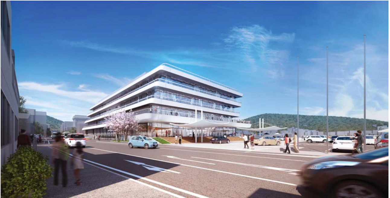
＜北側の道路から見た尾道市新本庁舎イメージ＞ テナントスペースは、この道路に面しています。
