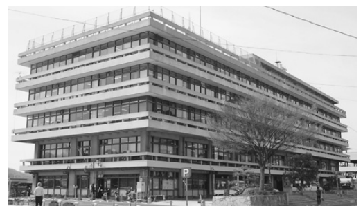
築52年の市役所本庁舎
