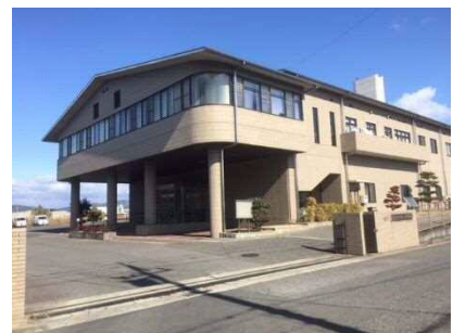
おのみち地区し尿処理場
