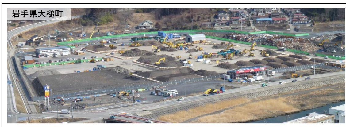
図 2.2.8 二次仮置場の例
