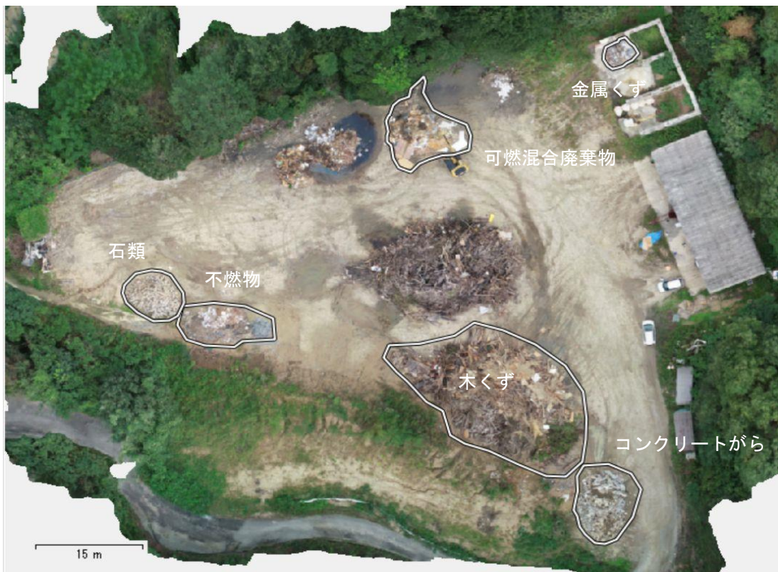
図 2.2.7 一次仮置場（平成 30 年 7 月豪雨における三成旧埋立地仮置場）
