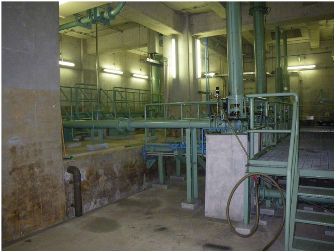
写真2 主ポンプ (モーター)
