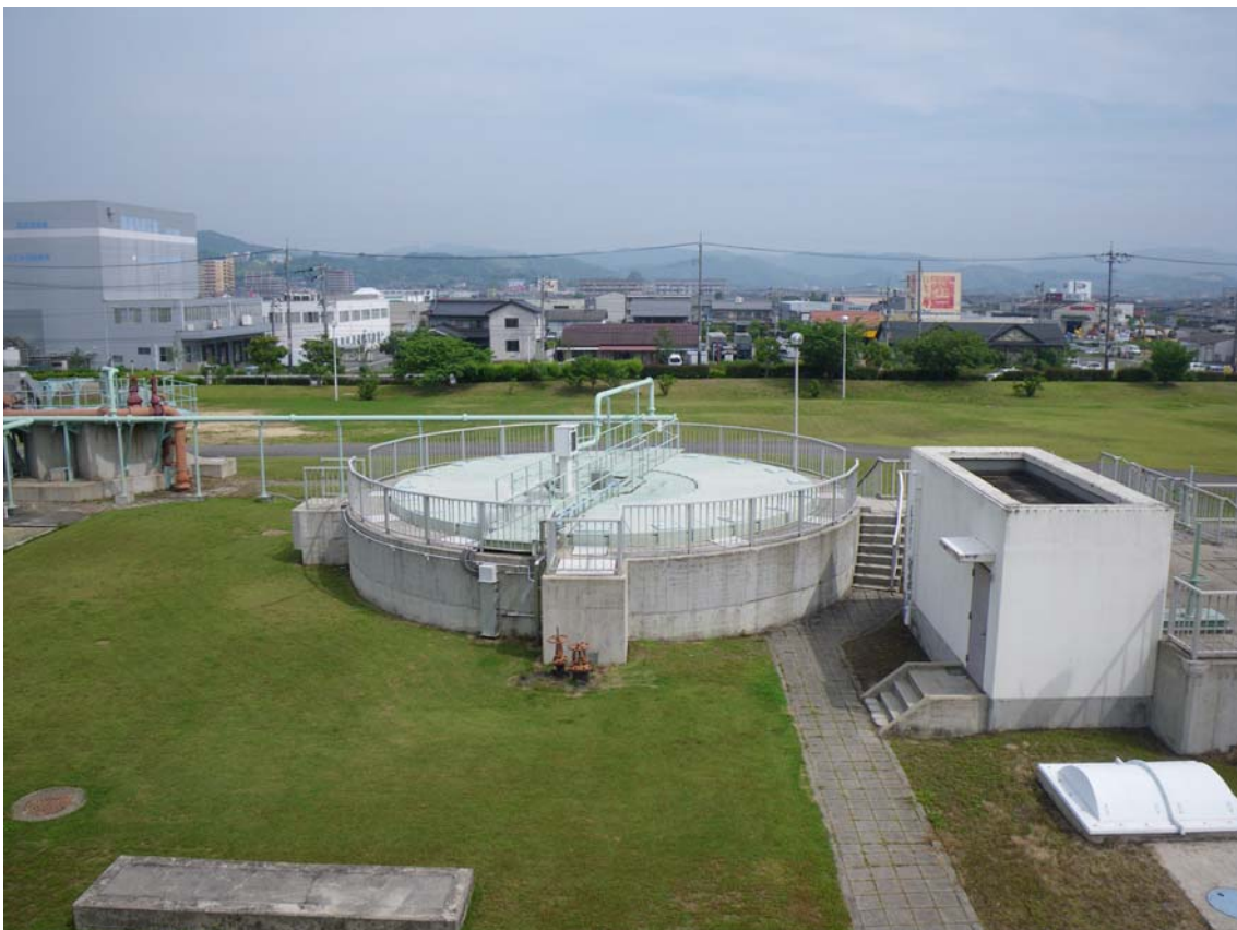
写真3 最初沈殿池
