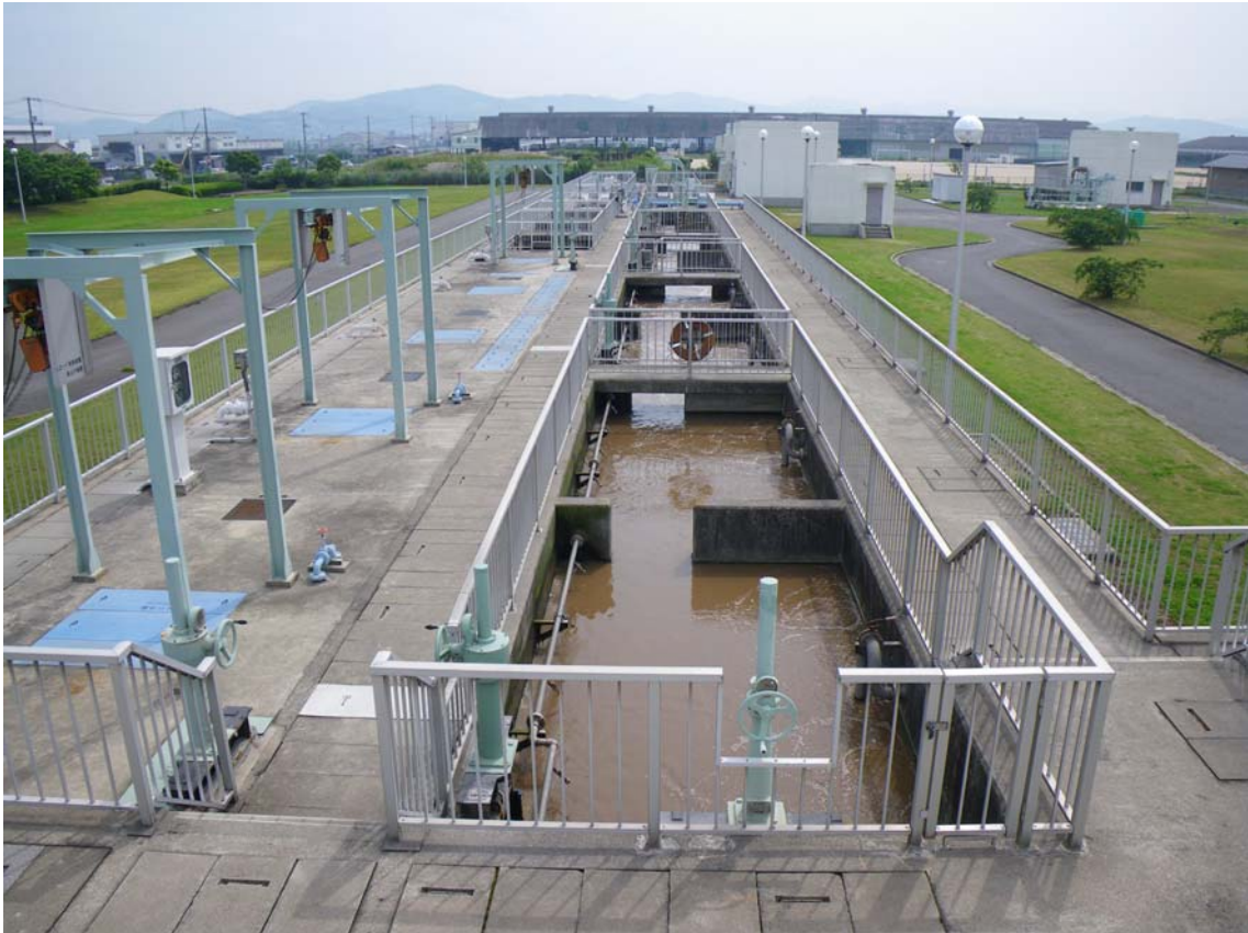
写真4 生物反応槽
