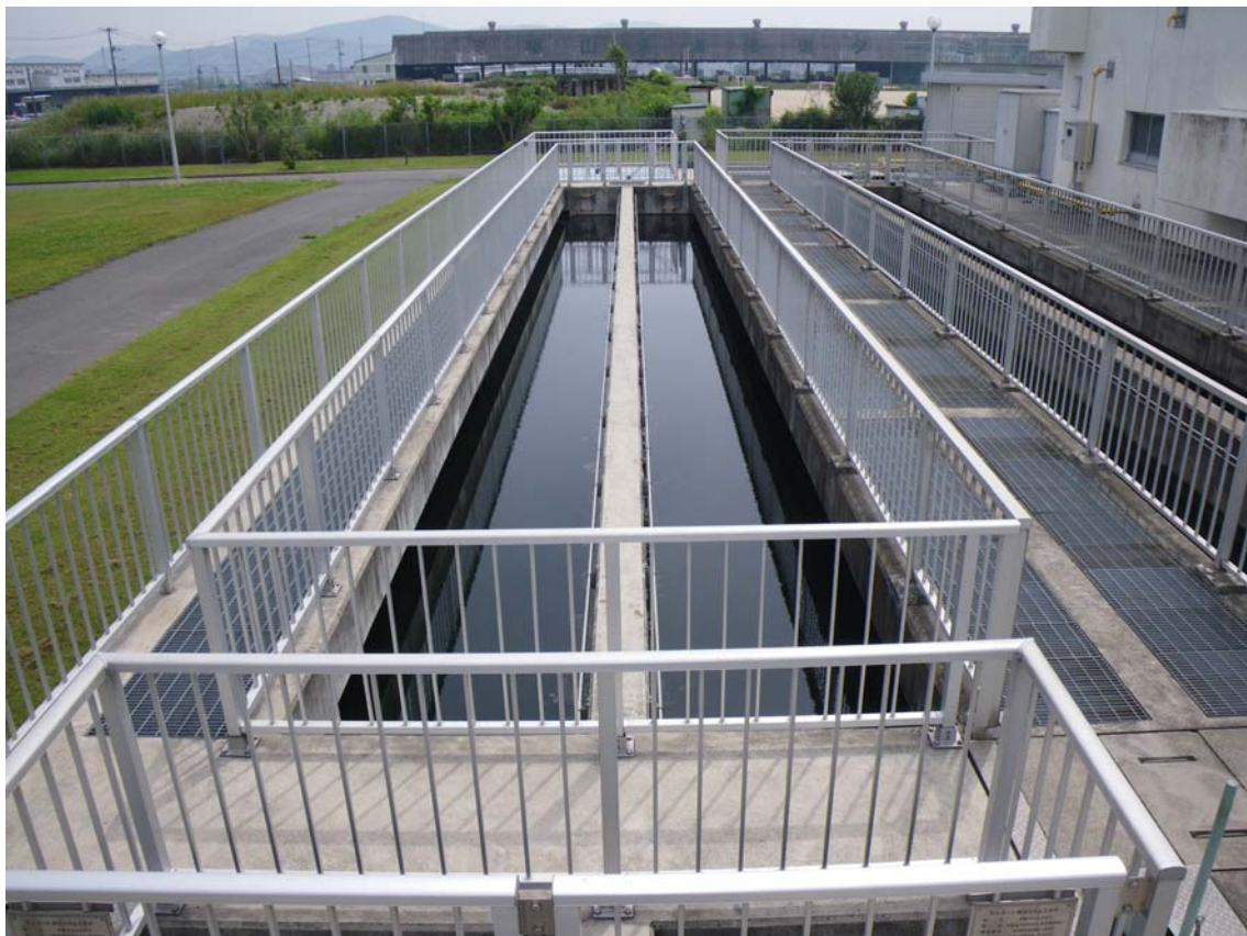
写真6 最終沈殿池
