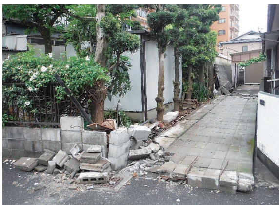
熊本地震でブロック塀が崩れた様子(本市撮影)
