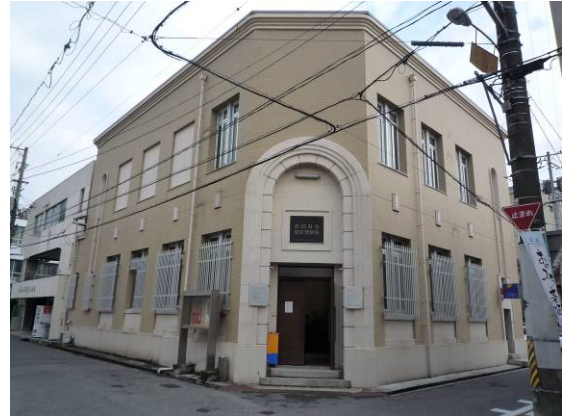
ルートに面して立地する旧尾道銀行本店 (尾道市重要文化財)
