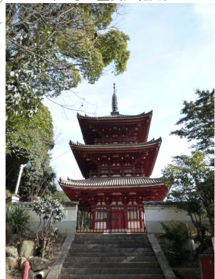
西國寺三重塔(重要文化財)
