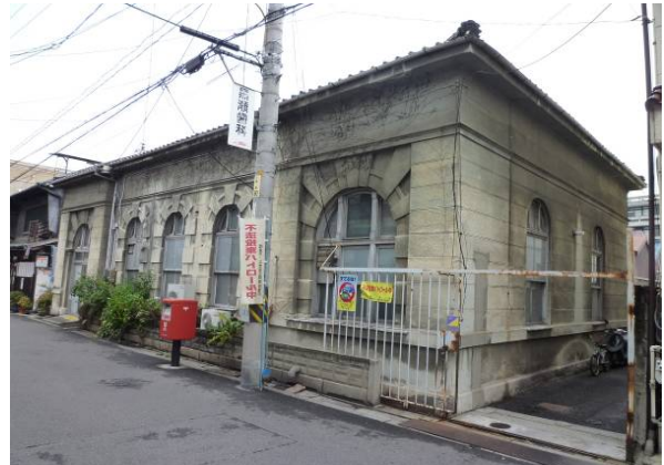
ルートに面して立地する旧住友銀行尾道支店
