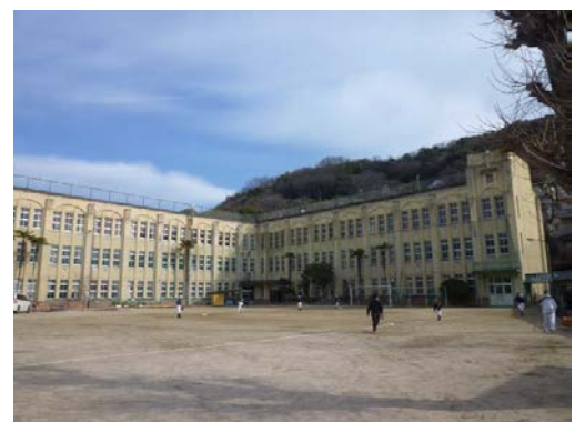
久保小学校（昭和8年建築）
