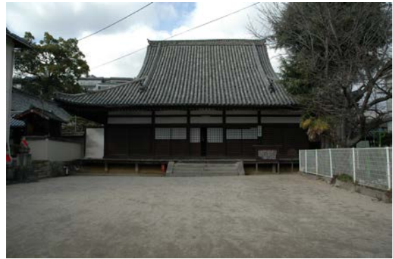
常称寺本堂(重要文化財)
