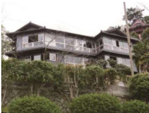
写真 3-9 再生された空き家(尾道市)
