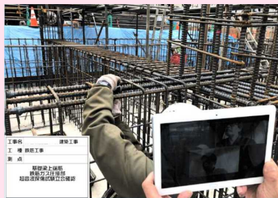
Webカメラを利用した遠隔検査
