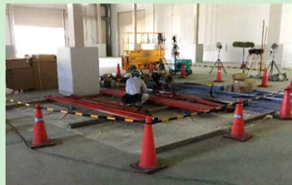
工事エリアの区画を設定して作業
