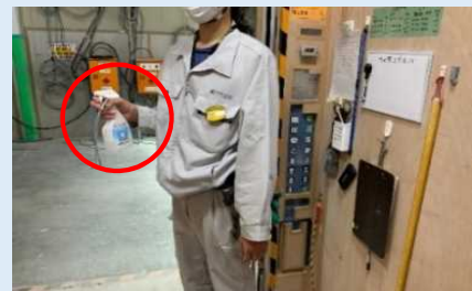
EVの操作盤等の消毒を徹底
