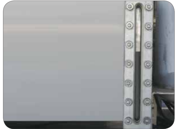
受液器液面計の液面位置
