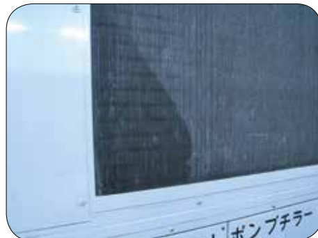
熱交換器の油のにじみ
