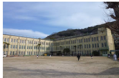
久保小学校（昭和8年建築）
