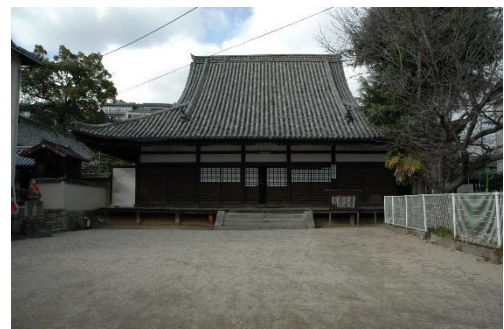
常称寺本堂（重要文化財）
