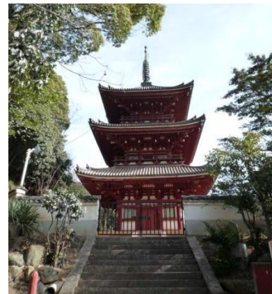
西國寺三重塔（重要文化財）
