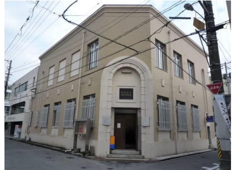
祭りのルートに面して立地する旧尾道銀行本店（尾道市重要文化財）
