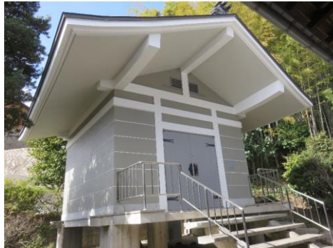
光明寺収蔵庫改修工事完了後
