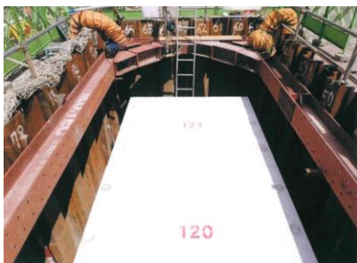
防地川改修工事
