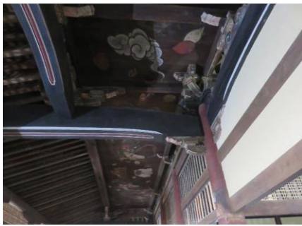
本堂内装工事
