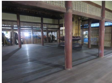
本堂内部組み立て工事
