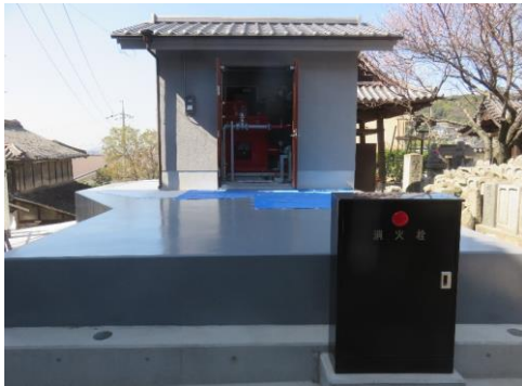
西郷寺防火水槽及びポンプ室等整備工事
