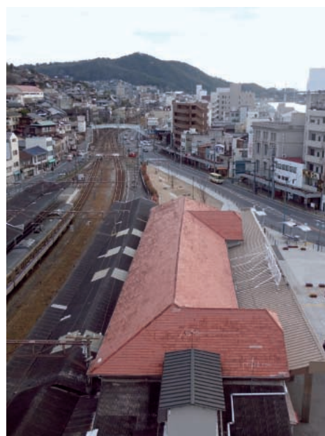
J R山陽本線尾道駅駅舎
