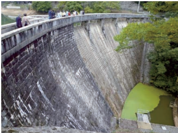
久山田貯水池堰堤
