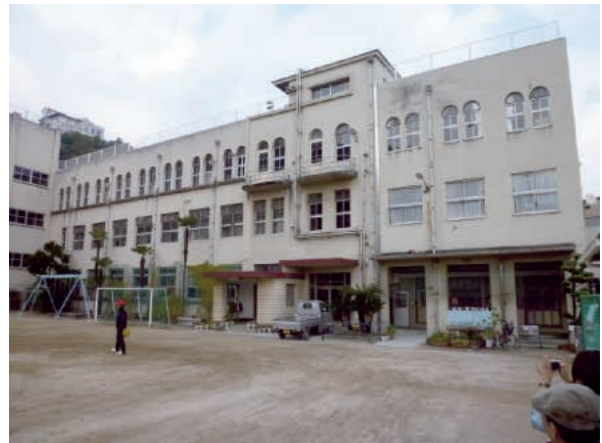
土堂小学校校舎
