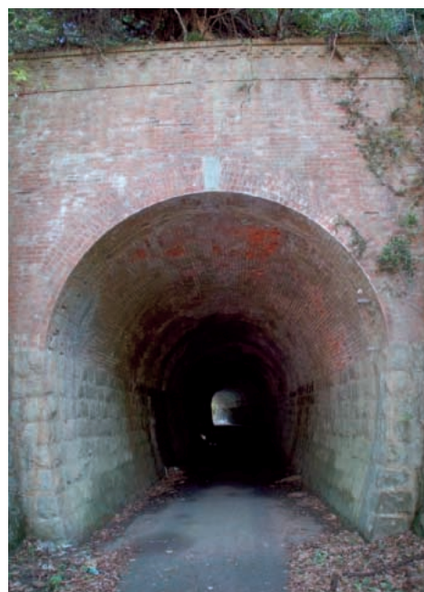
旧尾道鉄道のトンネル
