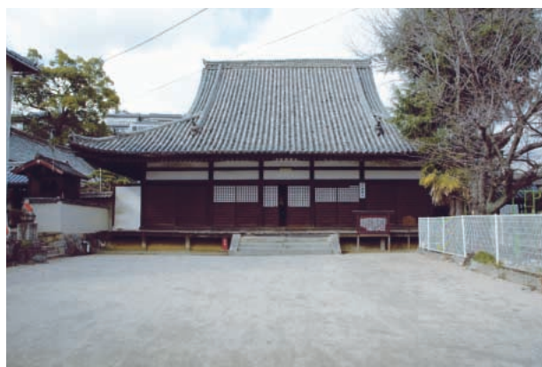
常称寺本堂（重要文化財）
