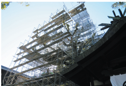
足場を組んでの枯れ枝の剪定の様子(平成28年度)
