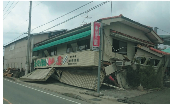
熊本地震で建物の一部が崩れた様子(本市撮影)
