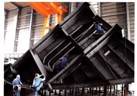
船体ブロックの組立作業
