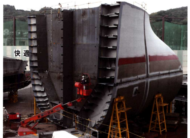
巨大な船体ブロック
