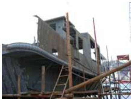
客室部分のブロックを組み立てます。
