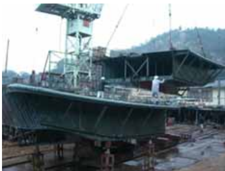
各ブロックを溶接で繋ぎます。
