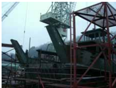
ブロックの組み立て完了です。
