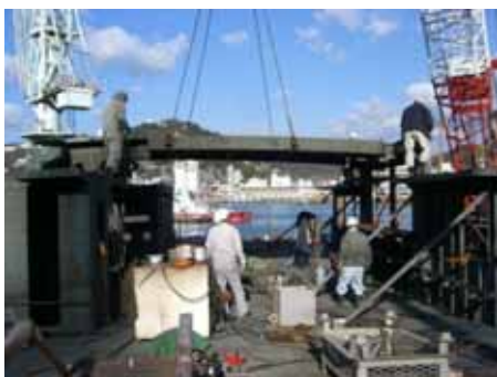
操縦室の台を取り付けます。
