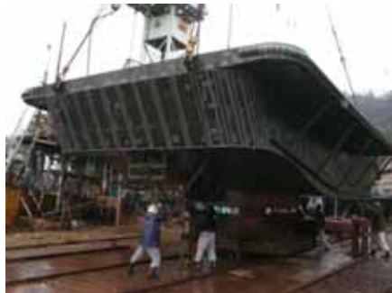
船首部分のブロックです。
