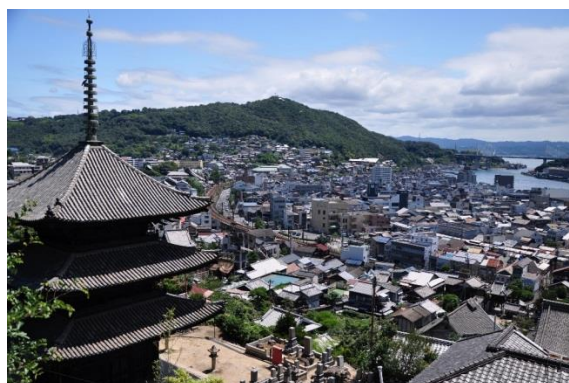
尾道水道と斜面地の景観
