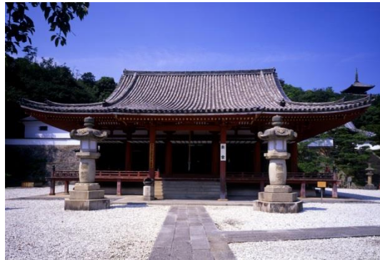
④ 西國寺金堂、三重塔
