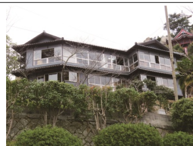
みはらし亭(保存修理後)
