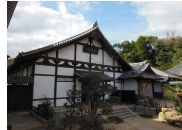
浄土寺保存修理後の様子
