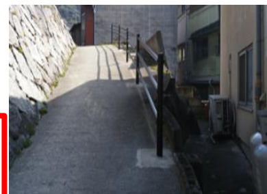
歩行者安全対策整備後 (H26)
