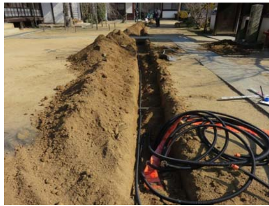
防災設備配管の敷設状況
