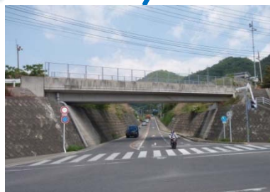
明原橋 L=30.7m (PC 橋) 1994 年架設 跨道橋 (県道)
