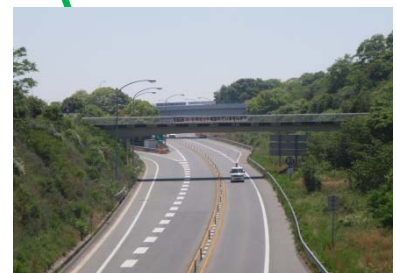
第 2 川尻跨道橋 L=43.4m (PC 橋) 1982 年架設 跨道橋 (しまなみ海道)
