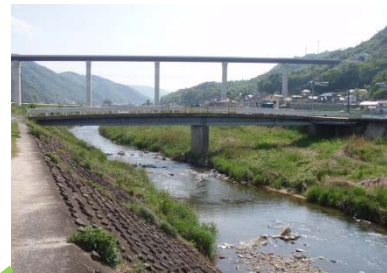
中根橋 L=44.6m (鋼橋) 1979 年架設
