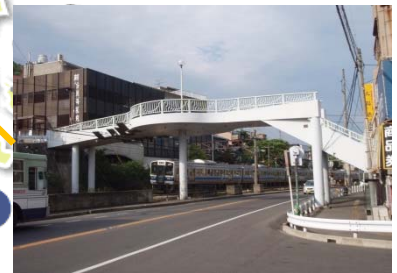
うず潮橋 L=35.2m (鋼橋) 1989 年架設 跨線・跨道橋 (山陽本線・国道 2 号)
