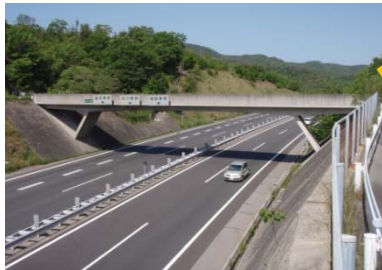
吉井谷橋 L=40.4m (PC 橋) 1993 年架設 跨道橋 (山陽道)
