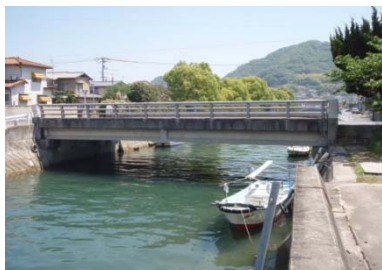
九軒島橋 L=17.8m (PC 橋) 1976 年架設
