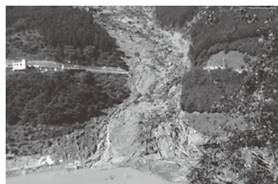
平成23年台風第12号による土砂崩れ (気象庁より画像提供)
