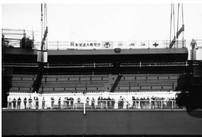
新尾道大橋建設工事の記録写真 1997（平成 9）～1998（平成 10）年 （故）土本壽美氏撮影 尾道学研究会提供
