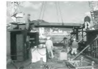
⑤操縦室の台を取り付けます。
