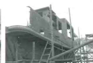
④客室部分のブロックを組み 立てます。
