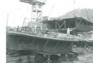
③各ブロックを溶接で繋ぎます。
