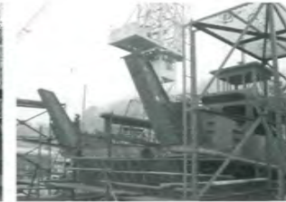
⑥ブロックの組み立て完了です。
