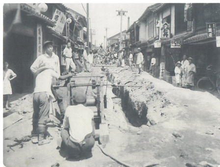
長江通りでの水道管敷設工事 『尾道市水道写真帖』より
