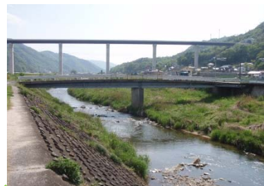
中根橋 L=44.6m (鋼橋) 1979 年架設
