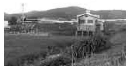
東新涯ポンプ場(整備中)
