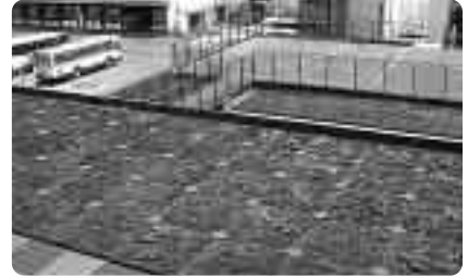
消防本部屋上緑化
