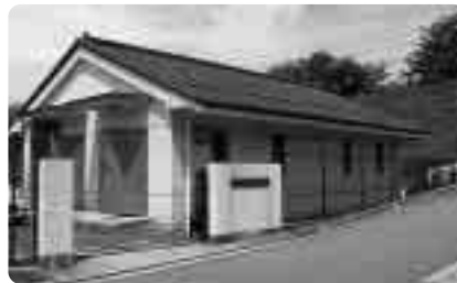
ふくしむら中継ポンプ場
