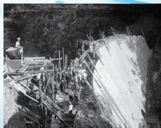
◀久山田貯水池(堰堤) 築造工事 / 側面より (大正13年)
