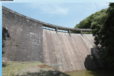
現在の 久山田貯水池堰堤▶
