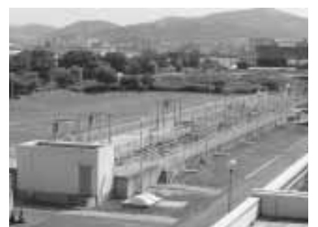
浄化センター
