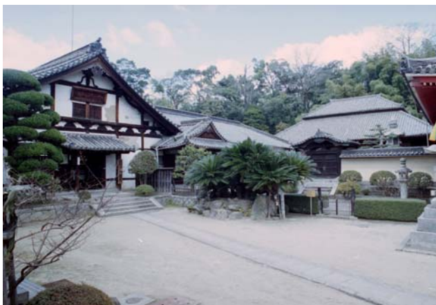
修理前の庫裏客殿
