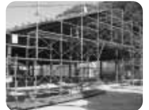
中庄公民館(建設中)
