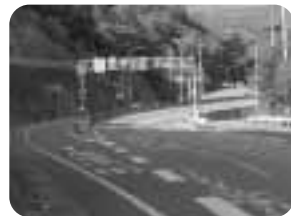
尾道大橋延伸道路
