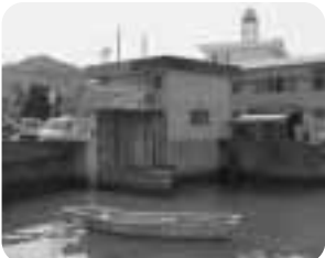
因島三庄町向浜のポンプ場
