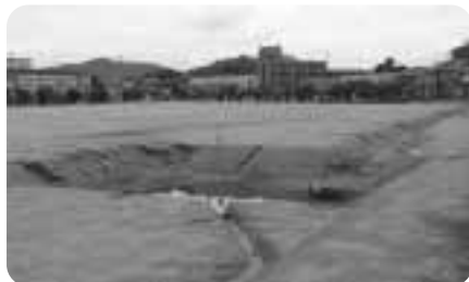
(仮称)市民センターむかいしま建設予定地
