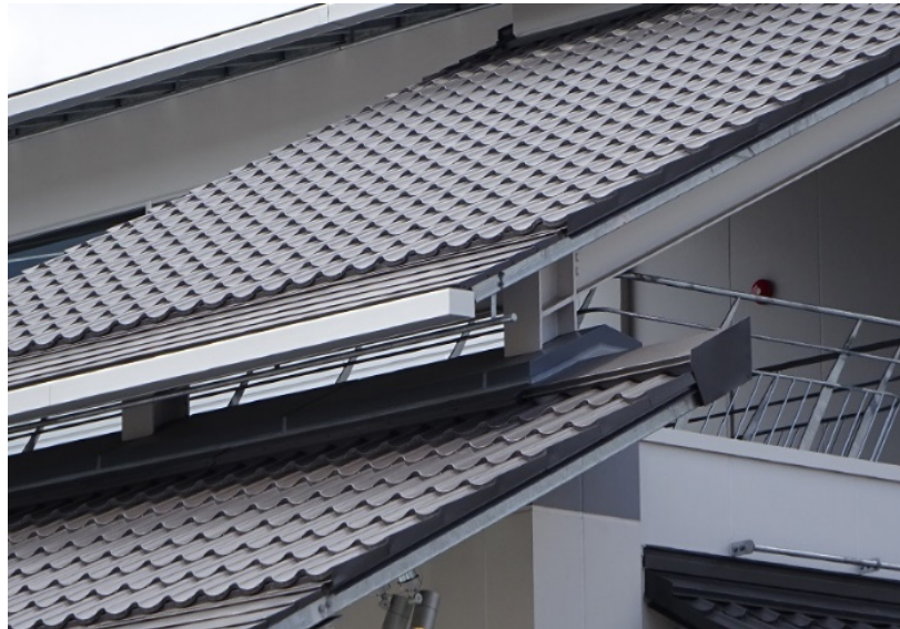
JR尾道駅の瓦風鋼板屋根
