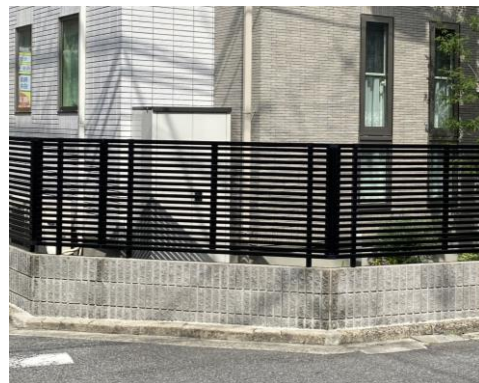
はつり処理のコンクリートの上に金属製の柵を設置（透視性を確保）
