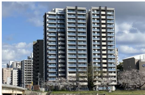
複数の色彩と壁面の凹凸を組み合わせ分節化している建築物の例
