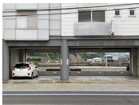
尾道水道側が透視できる1階部分のピロティ
