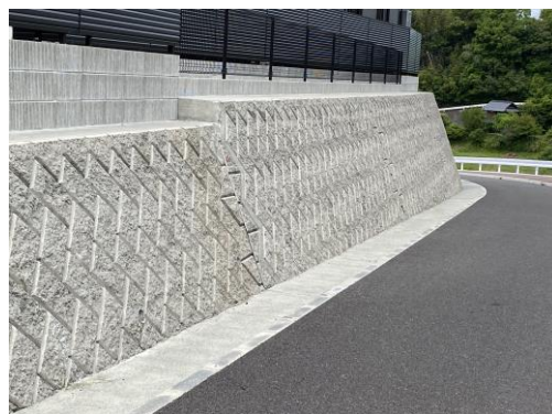
はつり処理したコンクリートブロックの擁壁
