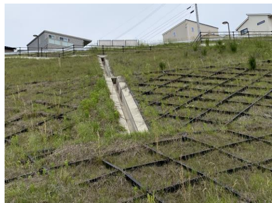
緑化による法面の保護・修景
