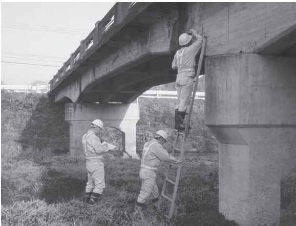
社会基盤老朽化に対する橋梁長寿命化事業の点検作業
