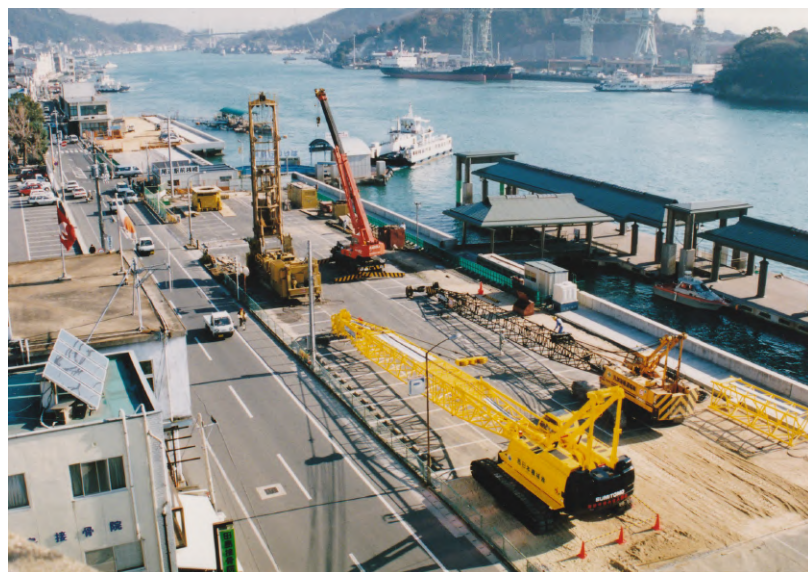
尾道ウォーターフロントビル建設始まる。平成 8 年（1996）12 月撮影。
