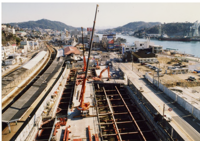
建設工事中の再開発ビル北棟。平成 10 年（1998）撮影。
