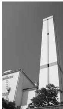
クリーンセンターの煙突内筒補修
