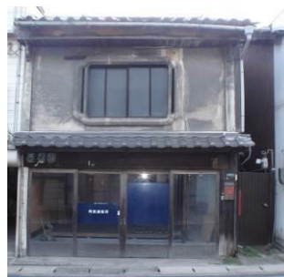
本瓦の葺き替え及び白漆喰仕上げの外壁により町屋を復元
