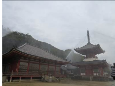
放水試験の様子
