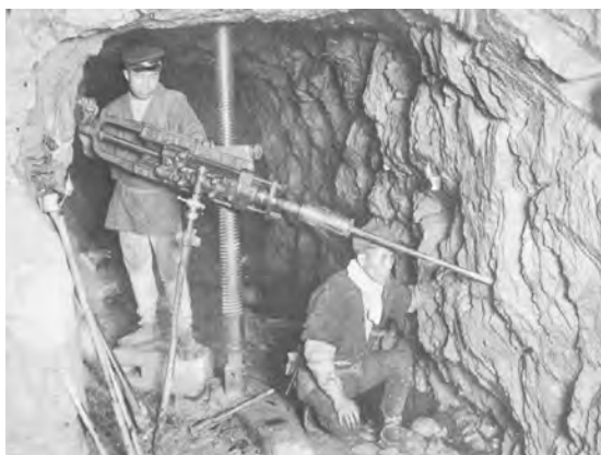
削岩機での採掘風景(明治30年代)
