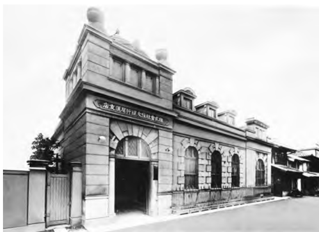
増築された当時の建物
