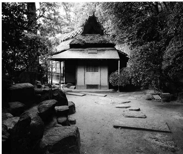
浄土寺庭園に移築された茶室「露滴庵」
