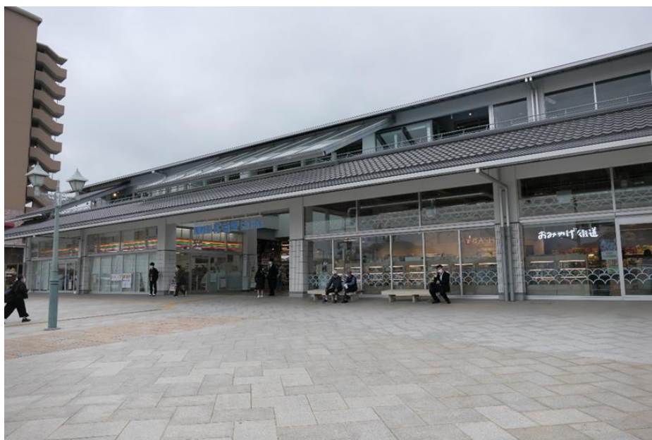
図 28 尾道駅の外観
